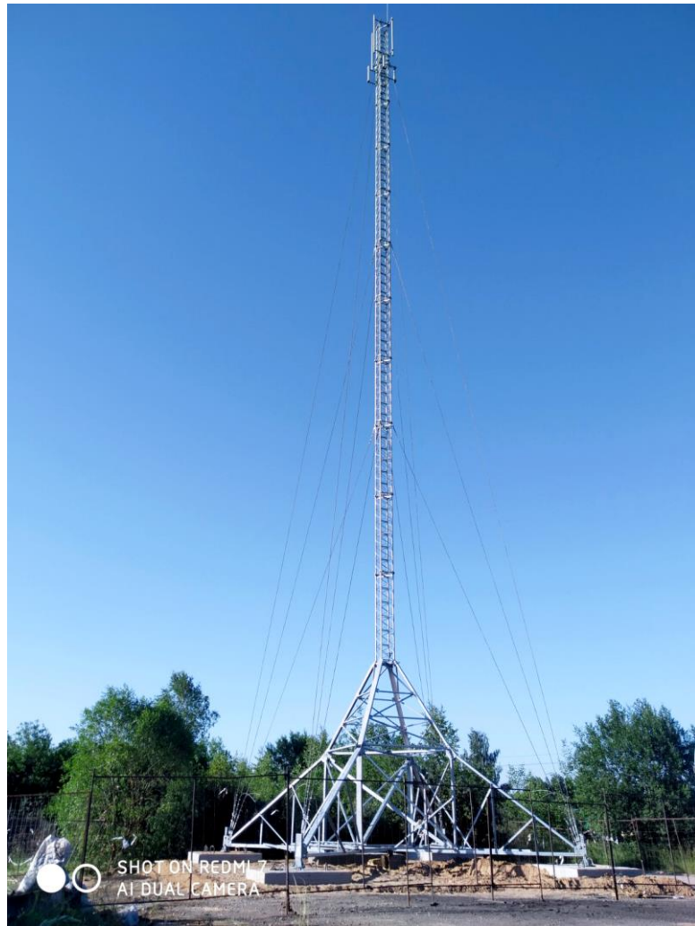
Рисунок 1.7 – Внешний вид металлоконструкций мачты высотой 39 м (объект-аналог)
