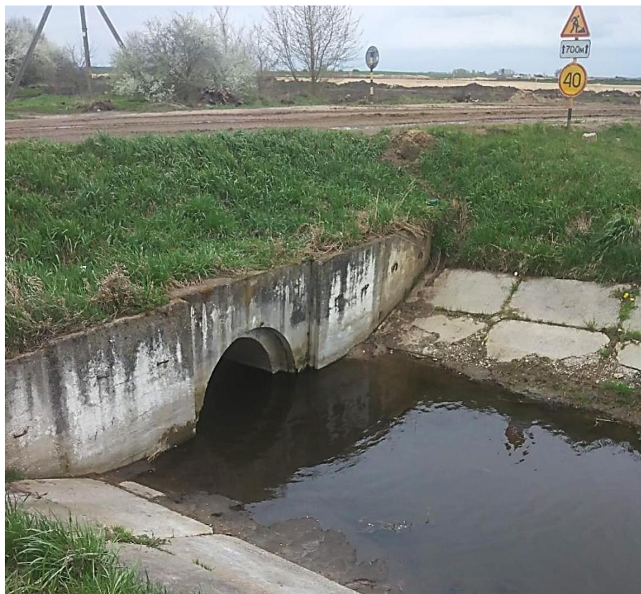
Рисунок 3 – Существующая железобетонная труба-регулятор
